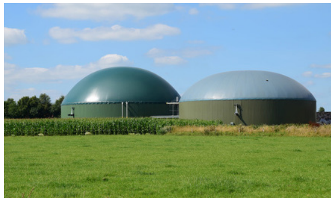
Exemple de méthaniseur pour le traitement des bio-déchets et déchets verts.
